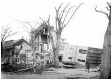
Pointe-à-Pitre, la place de la Victoire et les maisons qui la bordent après le passage d'un cyclone le mercredi 12 septembre 1928.
